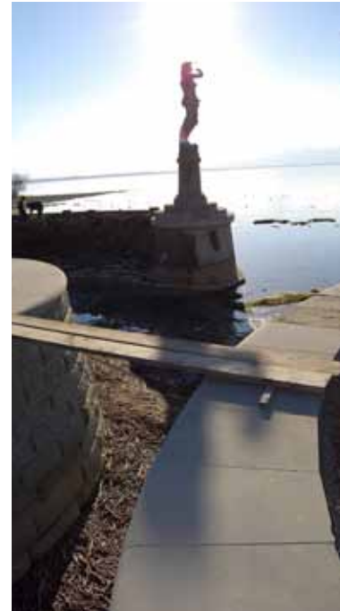
Durch das fehlende Geländer am Steg können sich Arbeiter durch einen Absturz schwer verletzen.
